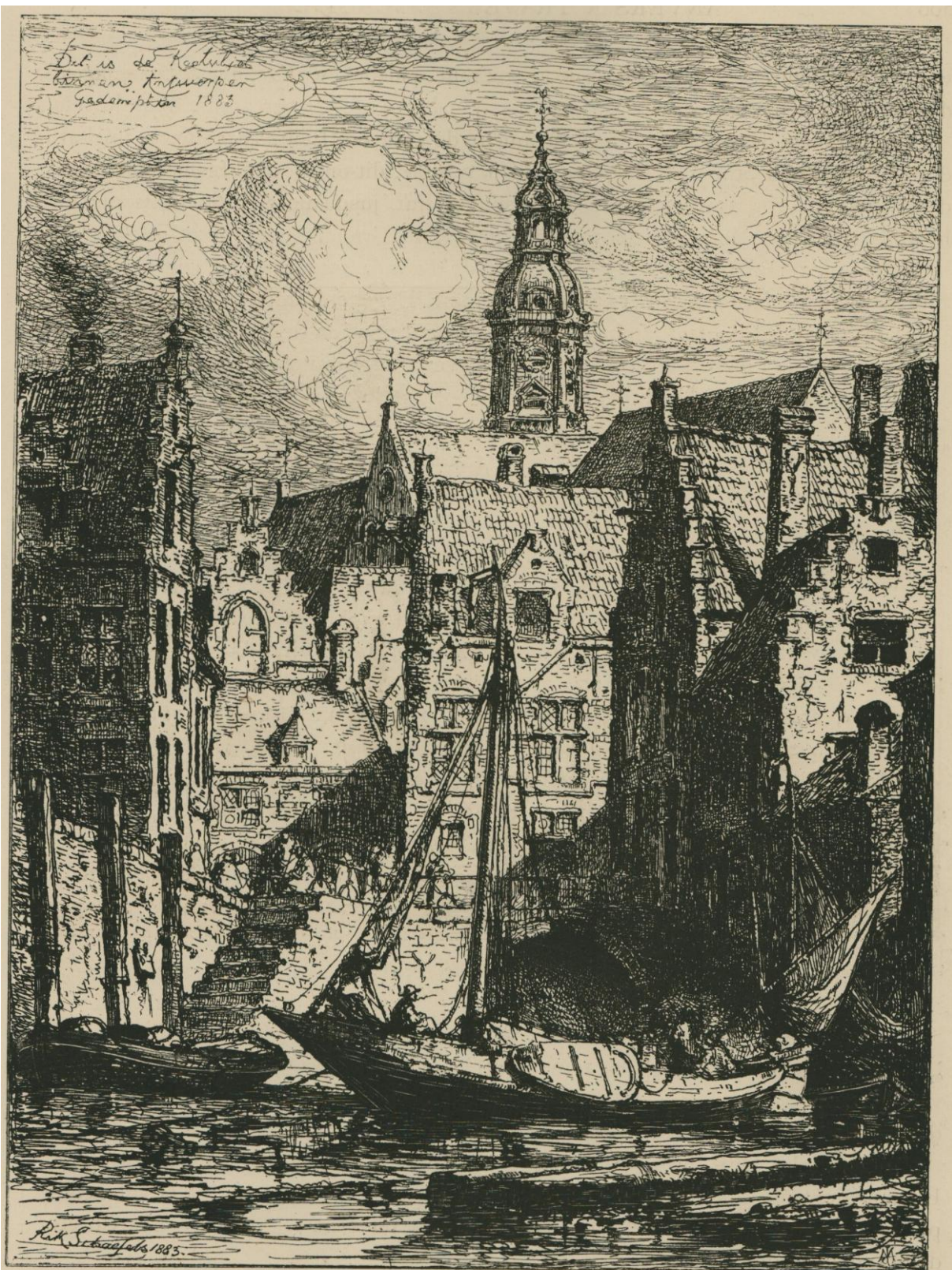
VUE DU CANAL AU CHARBON, COMBLÉ EN 1883.
